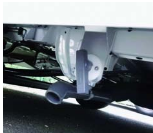
Exemple de vanne d'évacuation des eaux usées
