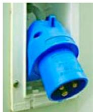
Le raccordement au secteur se fait au moyen d'un câble à brancher au camping-car sur la prise bleue P17. Elle est située soit à l'extérieur directement sur la paroi du véhicule, soit dans un local technique « Energybox » accessible de l'extérieur depuis un portillon.
