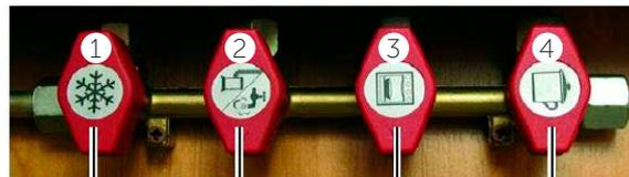
1•Réfrigérateur 2•Chauffage/Chauffe-Eau 3•Four 4•Plaque de Cuisson
