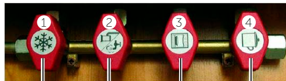
1•Réfrigérateur 2•Chauffage/Chauffe-Eau 3•Four 4•Plaque de Cuisson
